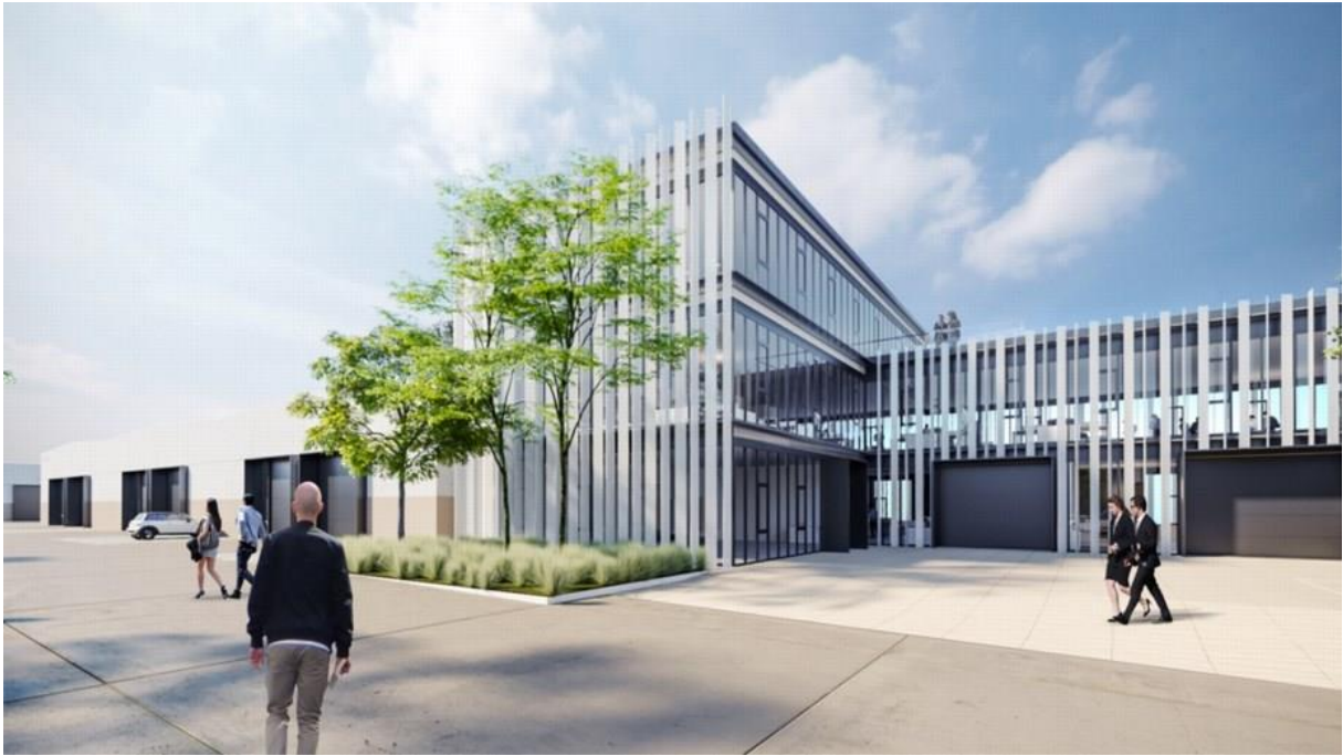
Le site NorthCity, à Haren, combinera logement et ateliers productifs. Photo: UNAA – Futurn – Inclusio – Citydev
